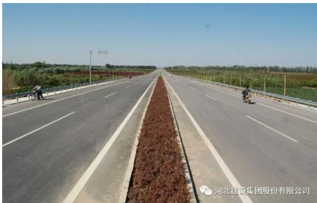
▲正在施工的白洋淀大道项目路段
